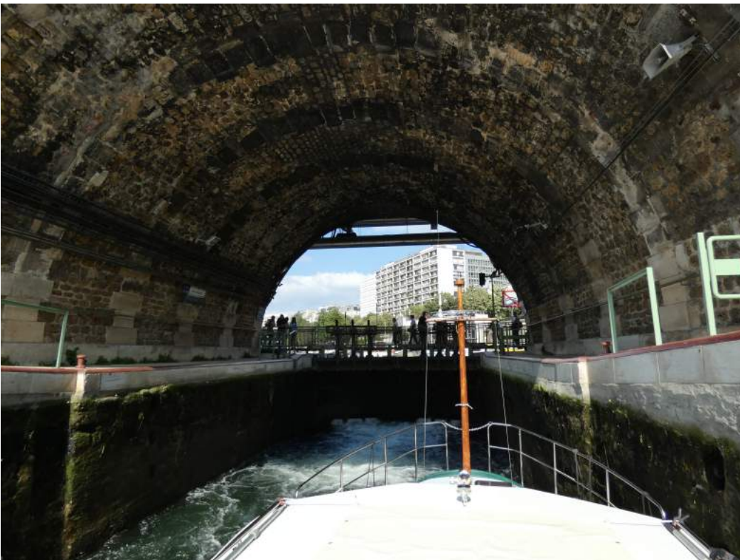
Écluse du port de l'Arsenal
